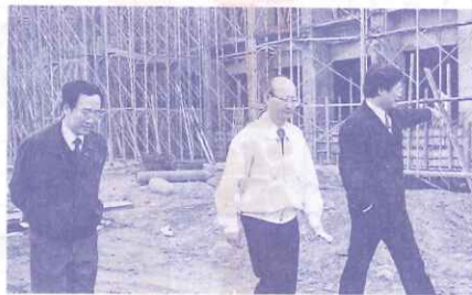
教育廳長二月十七日蒞校巡視校舍工程施工情形
